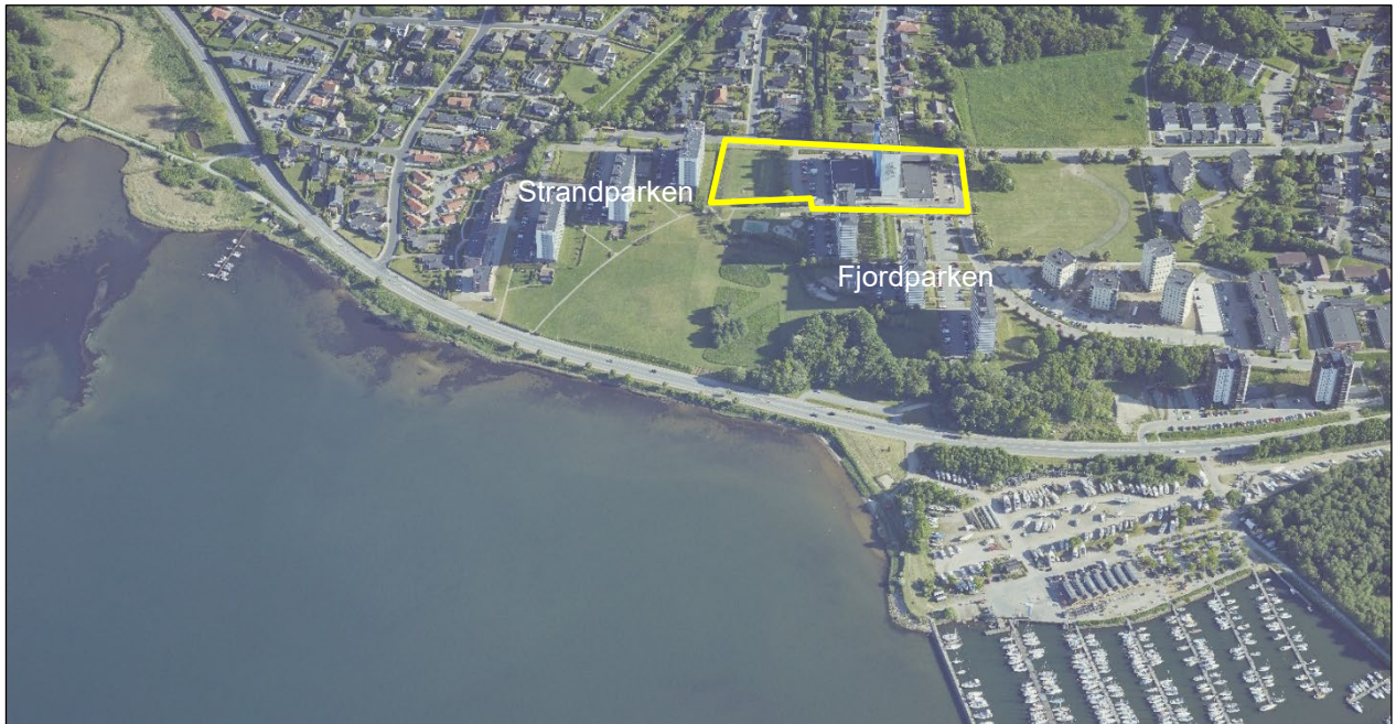
Figur 7. Skråfoto med planområdet (angivet med gul kontur) i forhold til de markante omkringliggende bebyggelser Strandparken og Fjordparken.
