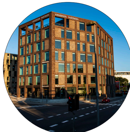
Foto - Nyt kontorbyggeri ved Campusområdet.
