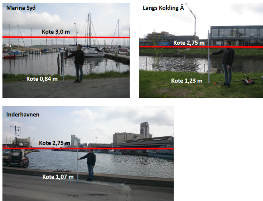
Figur 5: Billedet er en visualisering af, hvor højt vandet står i kote 3,0 meter og kote 2,75 meter i området omkring Havnen og Kolding Å.
